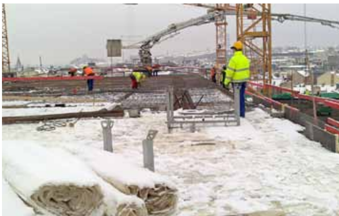
Obr. 1, 2: Zimní betonáž
