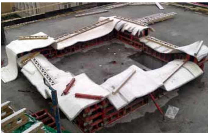
Obr. 3, 4: Ošetřování betonu v zimě
